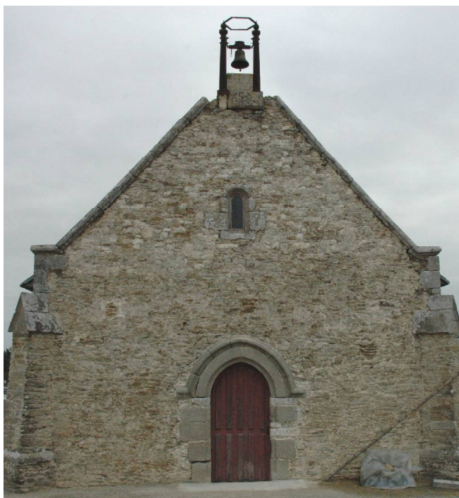
Coll. privée - La chapelle « dévêtue » de son enduit, montre ses pierres schisteuses.
